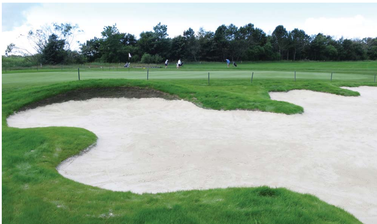
Figur 6: Den færdige bunker med revetteret bagkant. ▼
