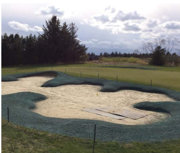
Figur 5: Sprøjtesåningen er overstået. Den blågrå mulch holder på det fine sand og skaber bedre spirebetingelser for frøet. ▶
