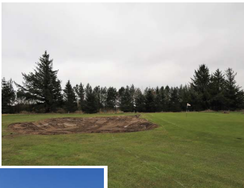
Figur 1 øverst til venstre: De nye kanter på bunkeren ved hul 6 mærkes af med spraymaling.
